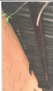
Foto 13: ESTRUCTURA DE TECHO
